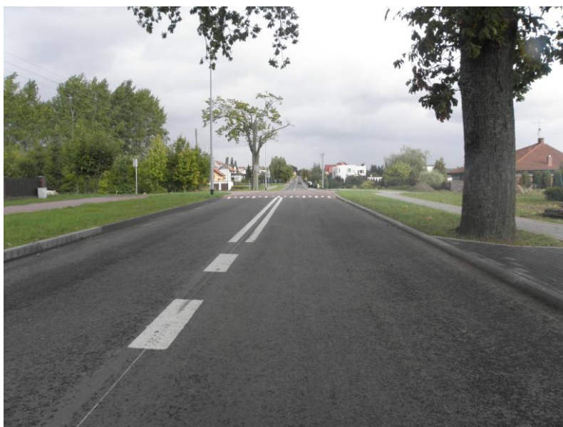
fot. ul. Kamienna po modernizacji
