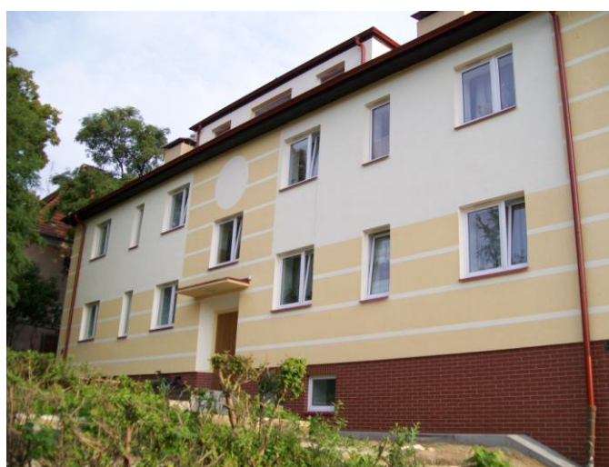
fot. wyremontowany i przystosowany na mieszkania budynek po policji
