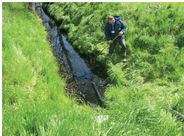
Usuwanie węglowodorów z rowu melioracyjnego po wycieku ropy naftowej z uszkodzonego rurociągu przesyłowego (fot. P. Trybuszewski)
