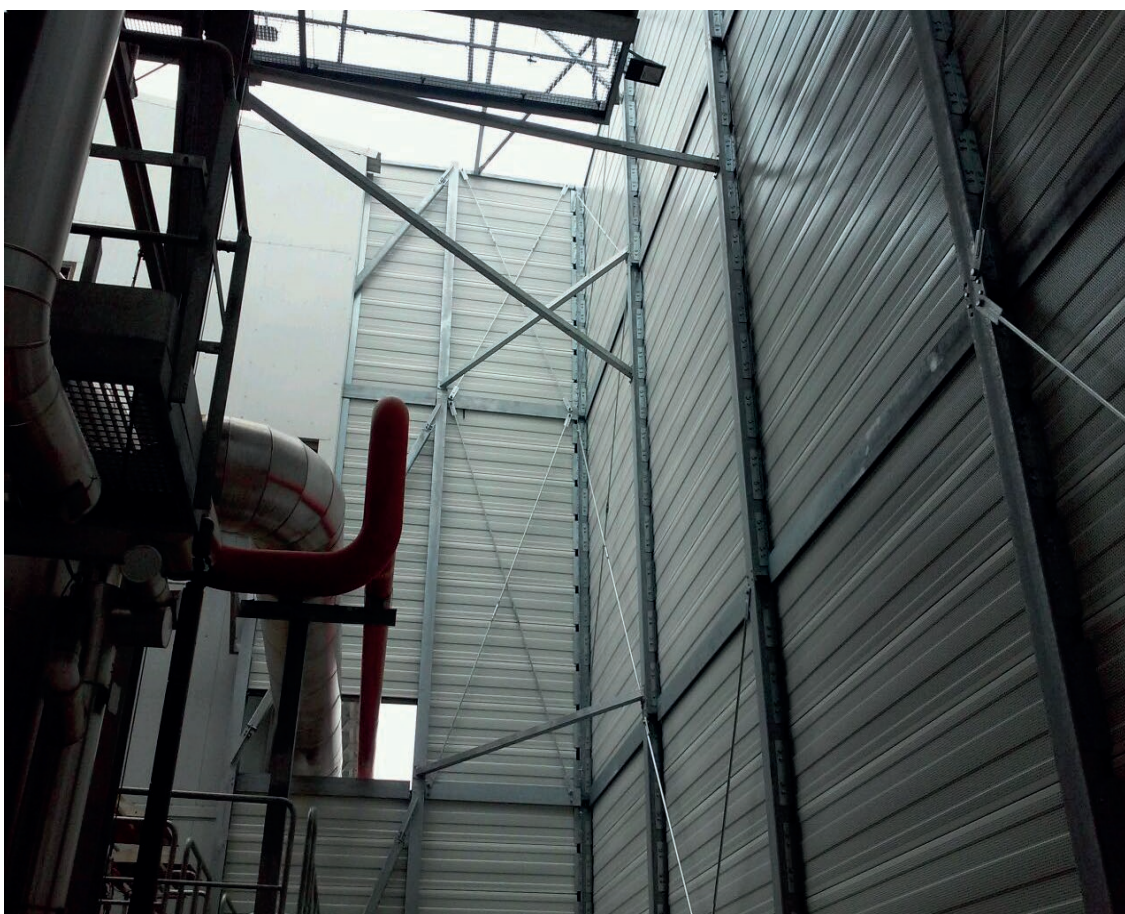
Ekrany akustyczne w zakładzie przemysłowym (fot. arch. WIOŚ Gdańsk)
