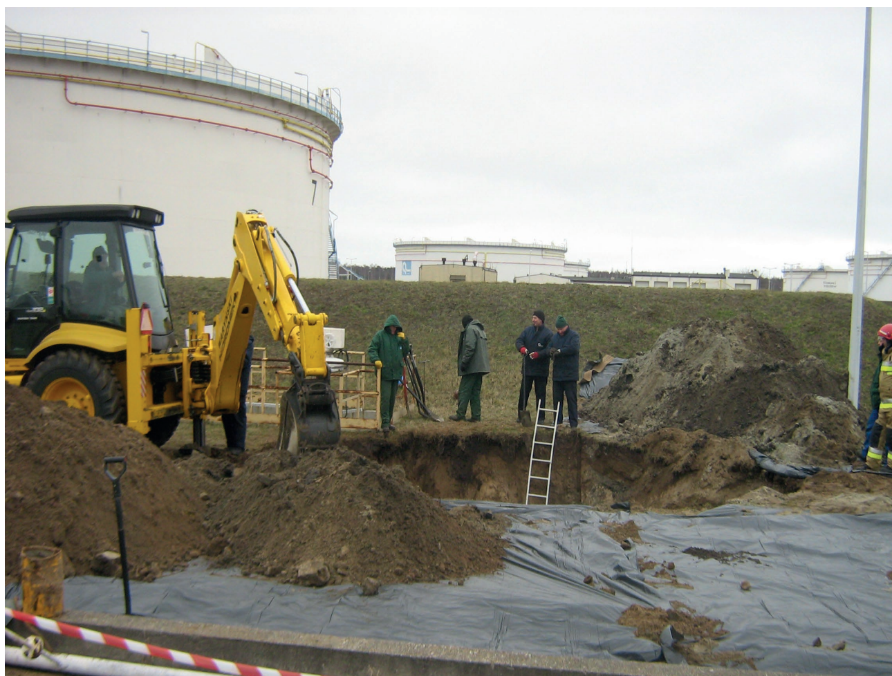
Usuwanie awarii na terenie zakładu (fot. P. Trybuszewski)
