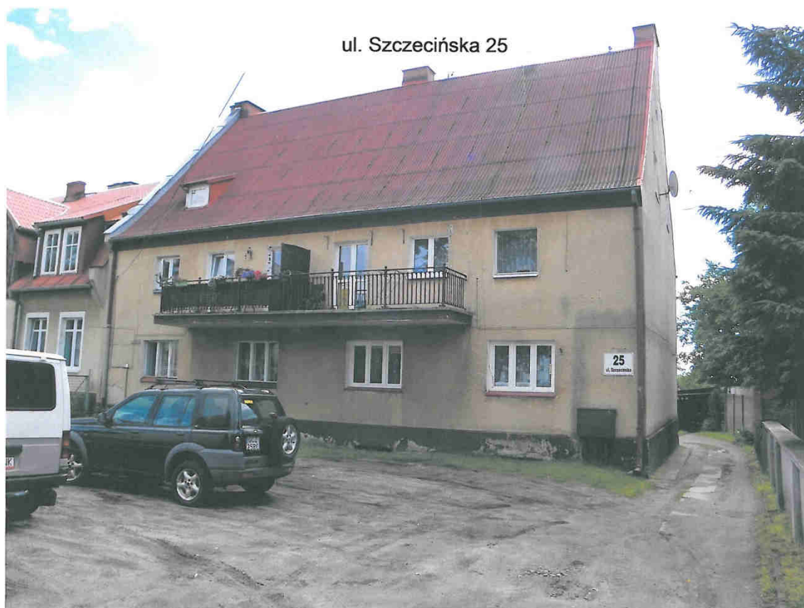
Budynek Szczecińska 25 od strony podwórza
