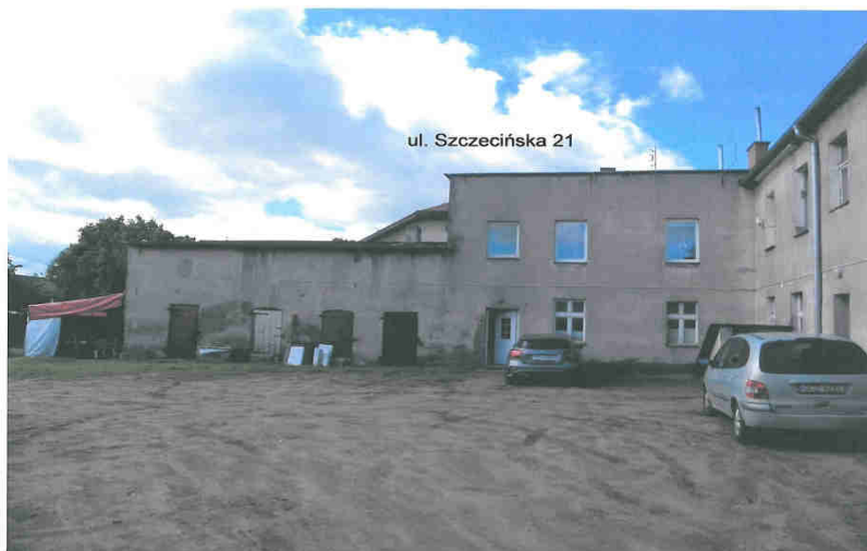
Budynek Szczecińska 21 - widok od strony podwórza
